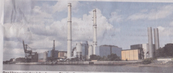
Der Ursprung des jahrelangen Streits: Das Kohlekraftwerk in Wedel.
